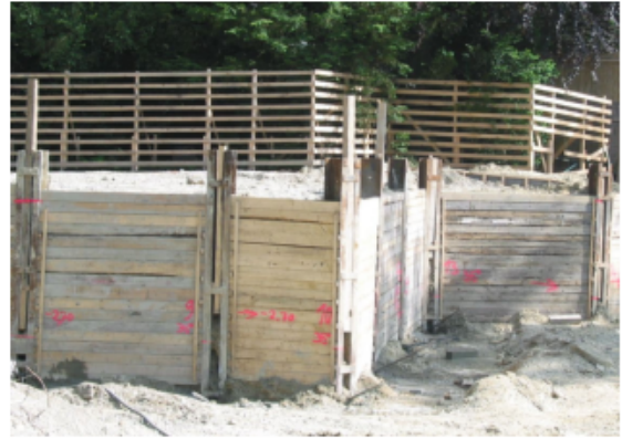
Abbildung 3: Berliner Verbau und Baumschutzzaun
