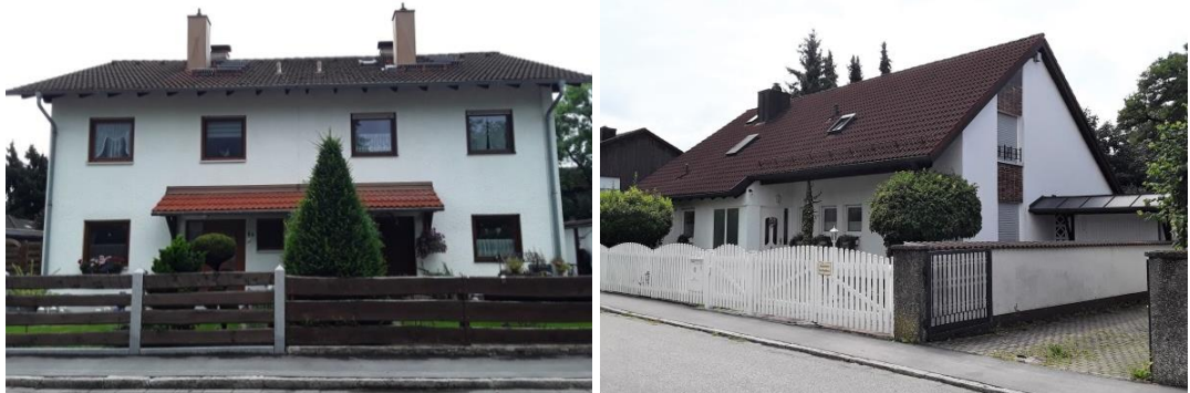
Abb. 9 Beispiel Haustyp A: Eichfeldstraße 6a-b Beispiel Haustyp B: Eichfeldstraße 12 © Planungsverband Äußerer Wirtschaftsraum München (PV)
