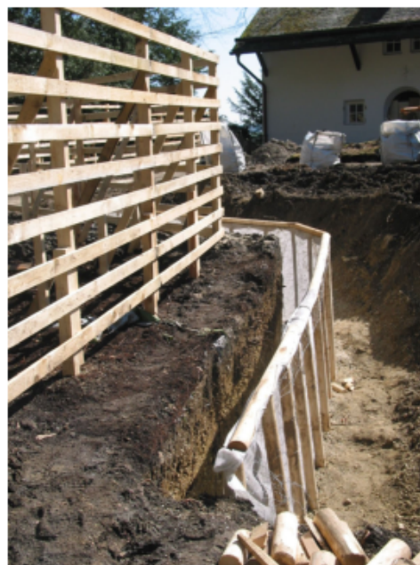
Abbildung 2: Baumschutzzaun und Wurzelschutzzaun – fachgerechter Wurzelschnitt - vor der Hinterfüllung mit humusreichem Substrat
