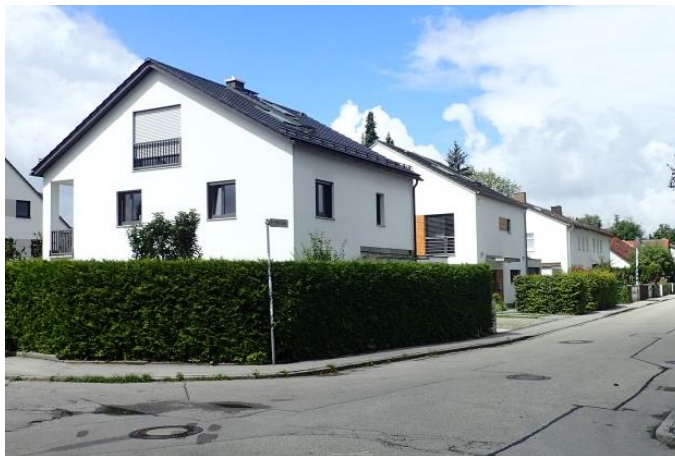
Abb. 10 Eichfeldstraße 18, 16 © Planungsverband Äußerer Wirtschaftsraum München (PV)
