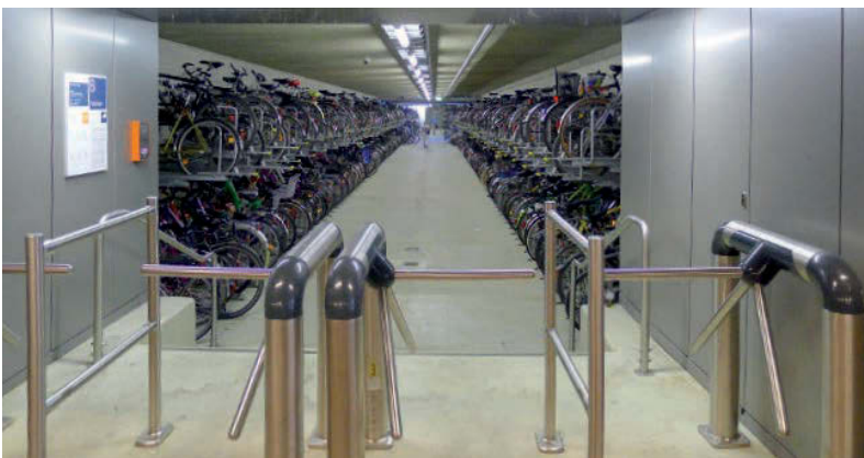
Bereits umgesetzt: S-Bahnhof Pasing, mit Fahrradabstellanlage
